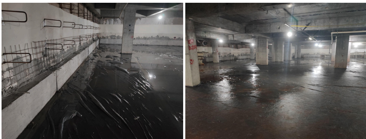
Imagens 18 e 19: Cura do concreto utilizando Bidim.
