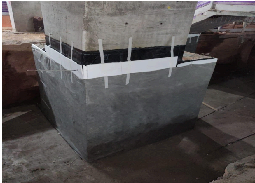
Imagem 5: Execução da Impermeabilização do poço.
