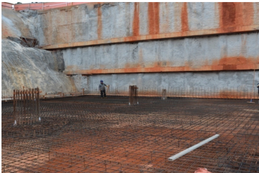
Imagem 1: Laje em concreto magro.
