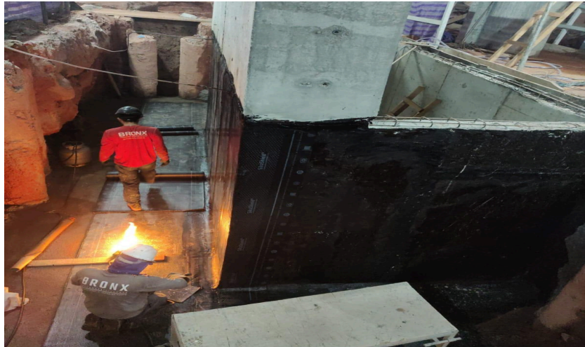
Imagem 5: Execução da Impermeabilização do poço.
