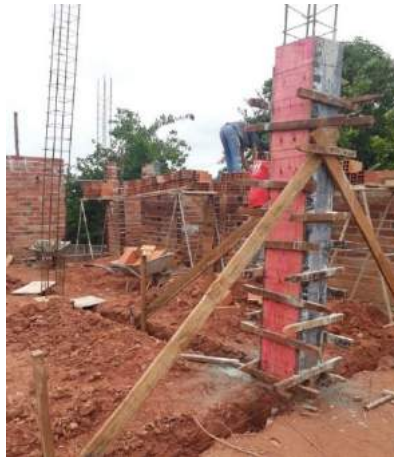
Figura 3 – Levantamento de Alvenaria e Armação para Concretagem de Pilares
