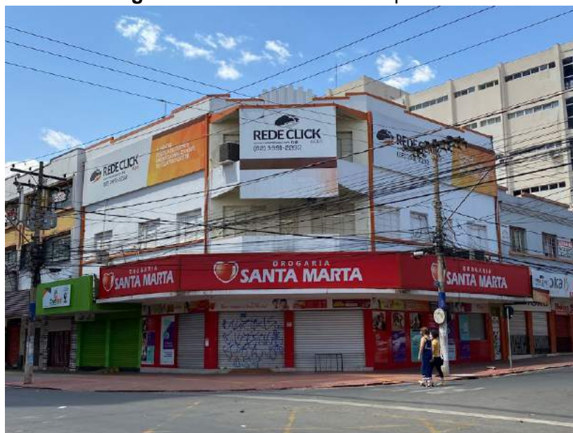
Fotografia 18 - Fachada coberta por letreiro.
