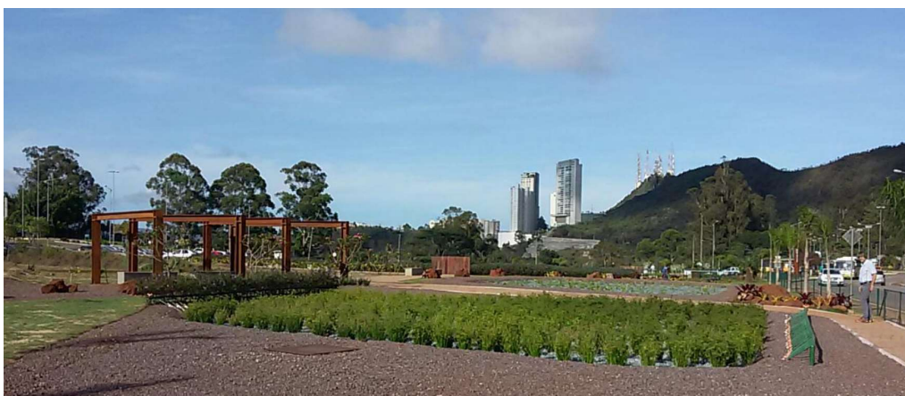
Figura 1 - Wetlands construídos aplicados a mineradora Vale
