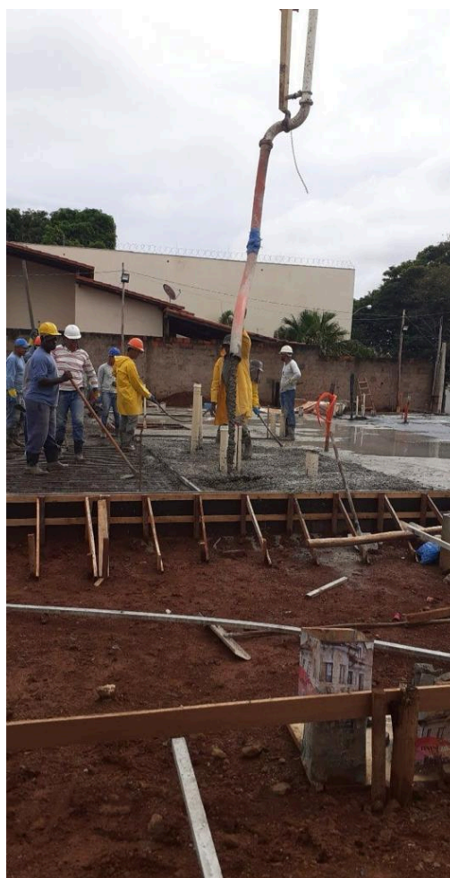
Figura 3: Fotografia de concretagem radier – Torre A
