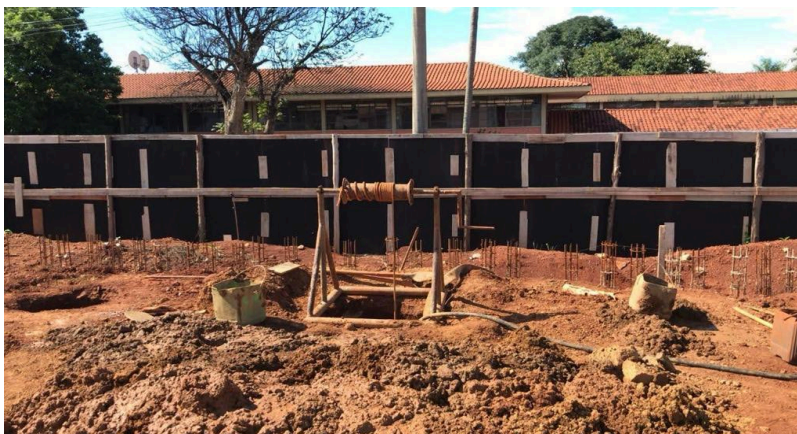
Figura 2: Fotografia de perfuração de tubulões – Torre A
