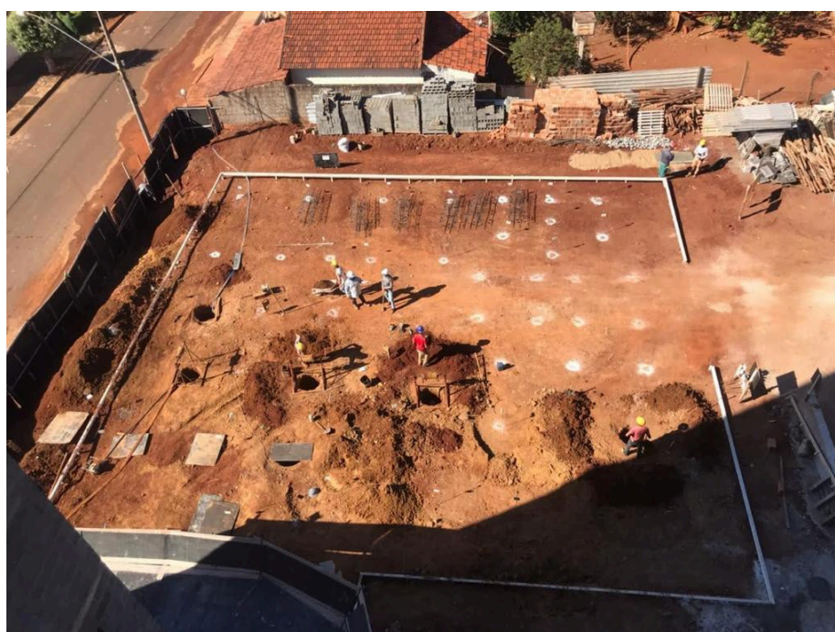
Figura 4: Fotografia de perfuração de tubulões - Torre B
