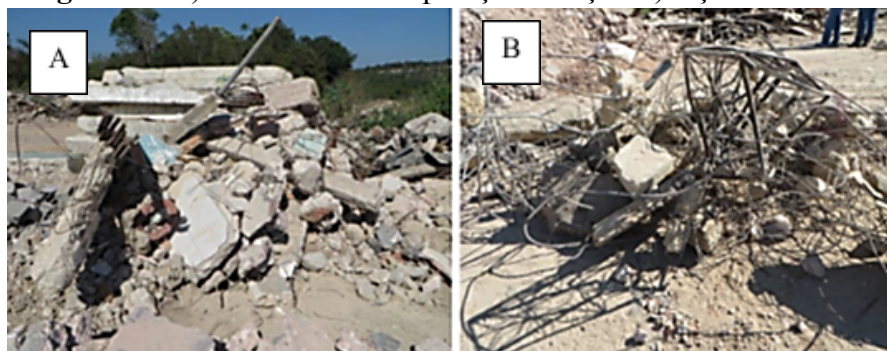
Figura 08: a) RCD antes da separação do aço. b) Aço extraído.
