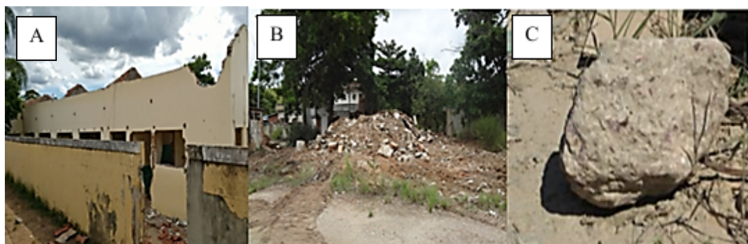
Figura 07: a) Área a ser demolida. b) Área demolida. c) Composição da estrutura.
